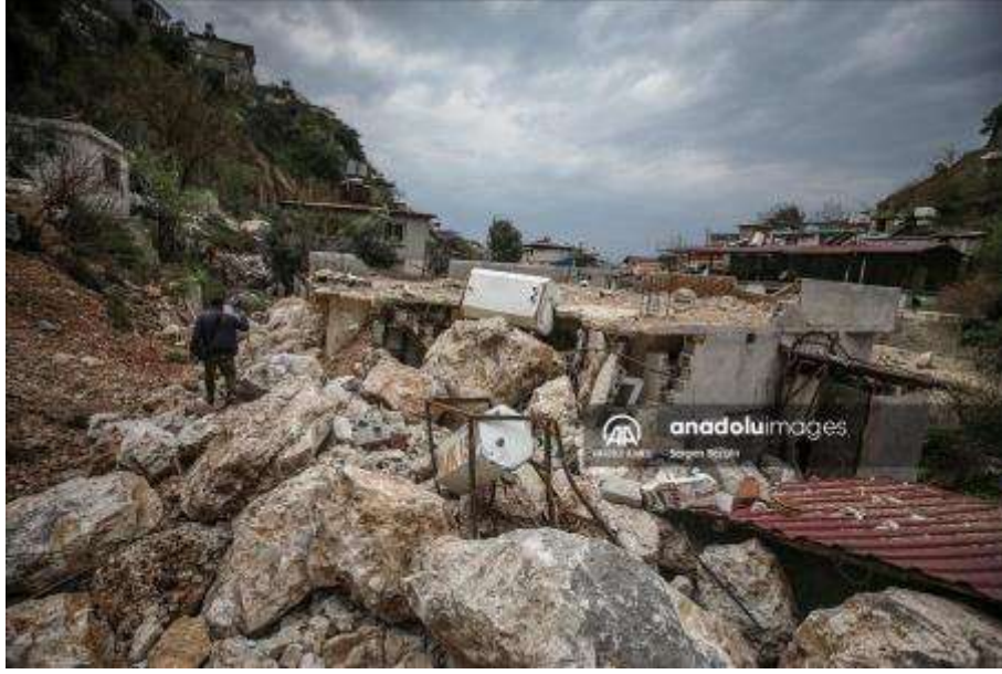
Foto 12: Burada Çatıdaki güneş enerjisi su depolarının oluşturduğu tehlike de gözükmemektedir.
